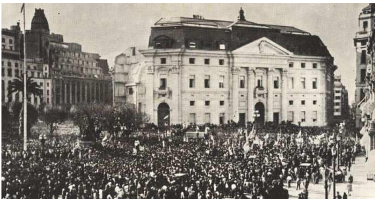
Fotografía del 17 de octubre de 1945. El 60 % de la obra estaba ya terminada.
