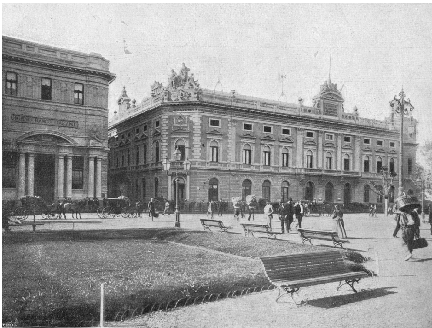
1895 | Banco de la Nación Argentina, vista general del antiguo edificio Fotografía en guarda del Archivo General de la Nación ID:AR-ARGN-AGN01-AGAS-Ddf-rg-11763
