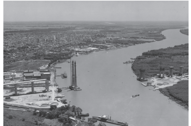
IMAGEN IX.1. Construcción del puente sobre el río Paraná de las Palmas
